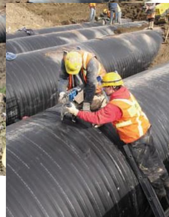
Les techniciens d'Uponor qui soudent une section du réservoir par extrusion.
