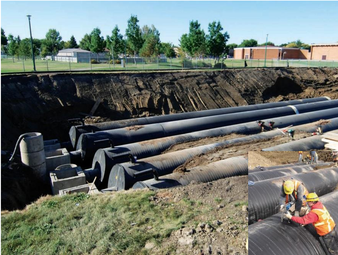
Les techniciens d'Uponor qui soudent une section du réservoir par extrusion.
